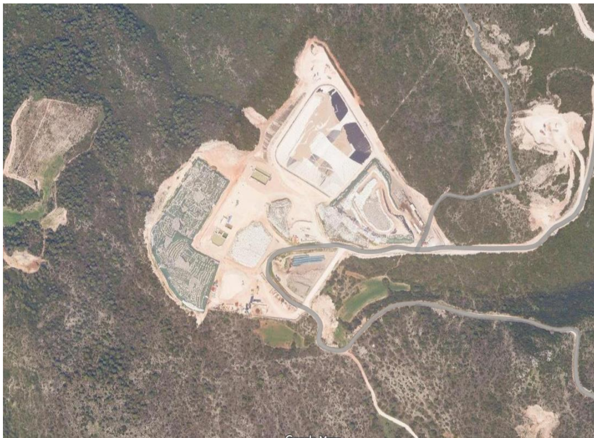
Εικόνα 4.3: Χώρος Υγειονομικής Ταφής Απορριμμάτων (XYTA) της Ζακύνθου.
