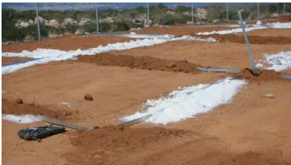
Εικόνα 4.2: Πλέγμα γείωσης εγκιβωτισμένο σε αλάτι.
