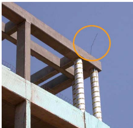
Εικόνα 1.3: Εφαρμογή θεμελιακής γείωσης ως ΣΑΠ.
