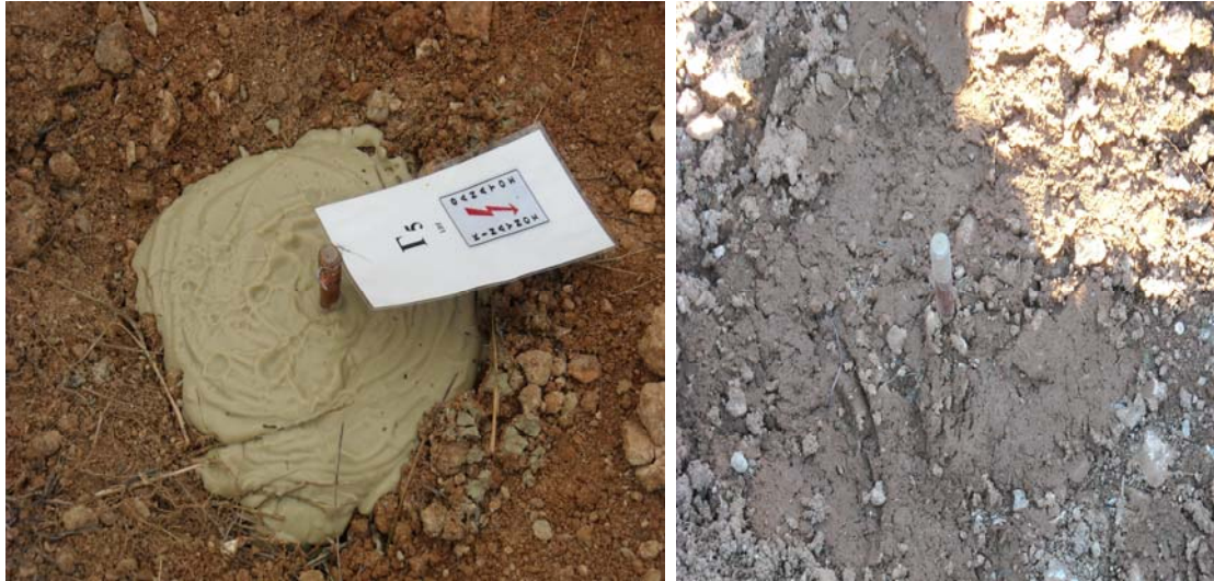
Εικόνα 5.5: Ηλεκτρόδια γείωσης εμβαπτισμένα σε βελτιωτικά υλικά εδάφους.
