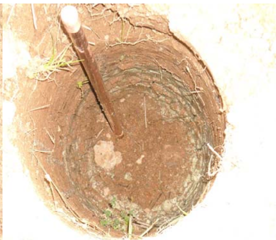
Εικόνα 5.4: Τοποθέτηση ηλεκτροδίων.
