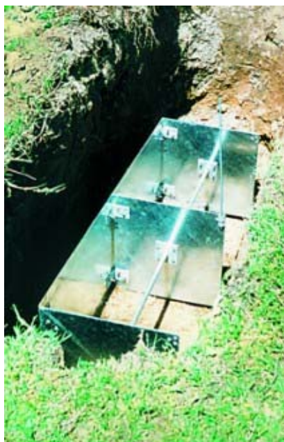
Εικόνα 1.1: Εγκατάσταση γειωτή τύπου “Ε”.
