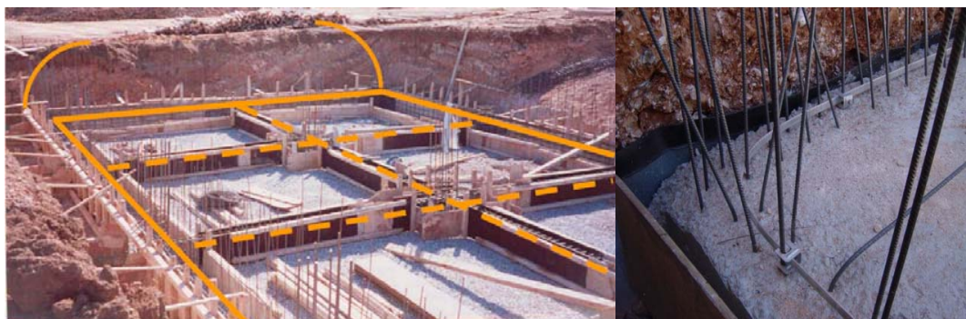
Εικόνα 1.2: Εφαρμογή σε δομική κατασκευή.
