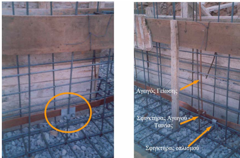
Εικόνα 1.4: Κατασκευαστικές λεπτομέρειες θεμελιακής γείωσης.
