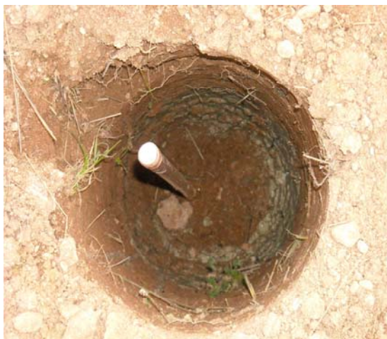
Εικόνα 5.4: Τοποθέτηση ηλεκτροδίων.
