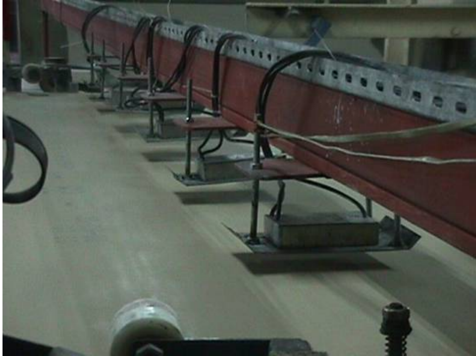
Σχ. 24 Τοποθέτηση των αισθητήρων πάνω από γυψοσανίδες
