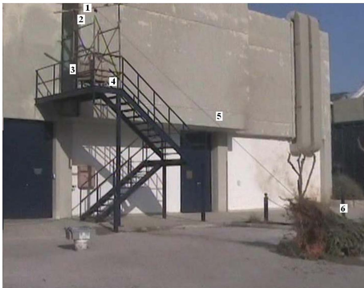
Σχήμα 5-1: Εικόνα που δείχνει το κρέμασμα του επιτόνου μέσω βαρούλκου. 1.Βαρούλκο, 2.Δυναμόμετρο, 3.Βάρος (δύναμη τάνυσης), 4.Μέτρο, 5.Επίτονος, 6.Θάμνος και χόρτα
