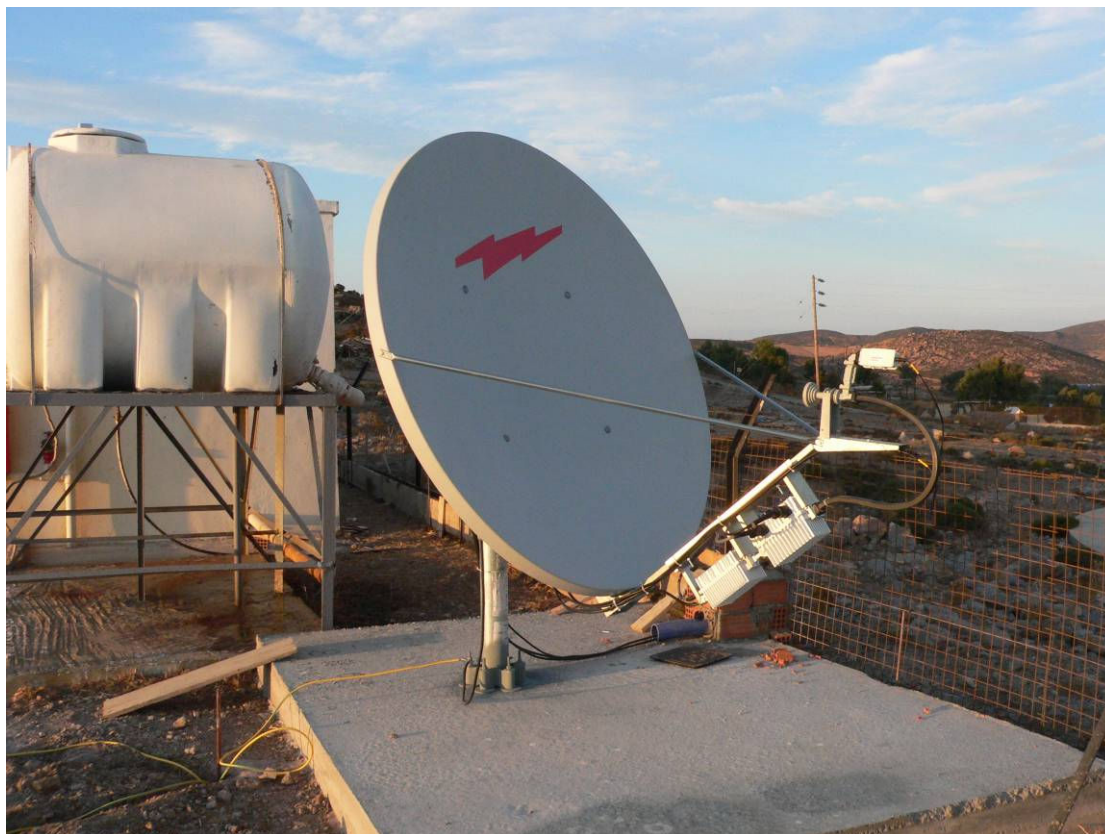
Εικόνα 18. Ο εξοπλισμός εξωτερικού χώρου τοποθετημένος στην κεραία
