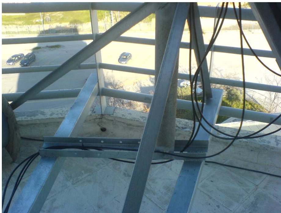
Εικόνα 10. Στήριξη της βάσης της κεραίας στην περίφραξη του εξώστη
