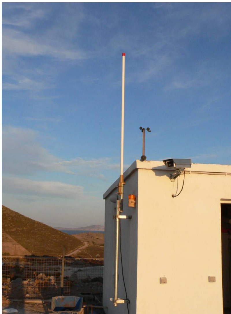
Εικόνα 19. Η εγκατάσταση της κεραίας VHF και της κάμερας IP
