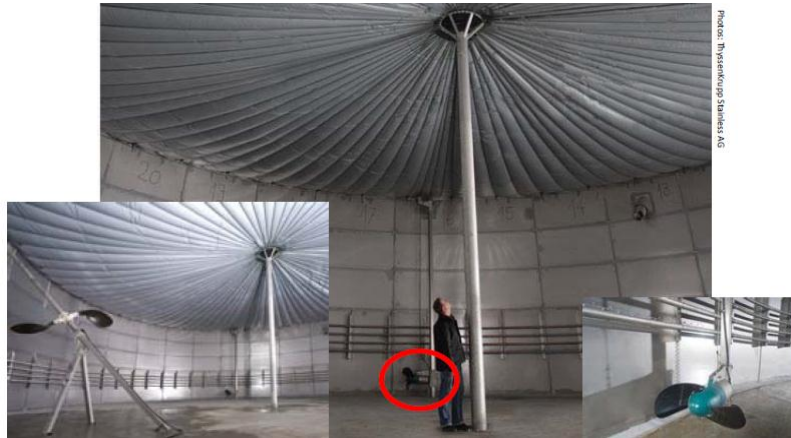
Σχήμα 1.3. Εσωτερικό κύριας δεξαμενής. Διακρίνονται η εύκαμπτη οροφή, ο αναδευτήρας και οι σωληνώσεις που μεταφέρουν θερμότητα στο μείγμα [Πηγή: Chair of Bioprocess Engineering, TU-Berlin-Thyssen Krupp Stainless AG]
