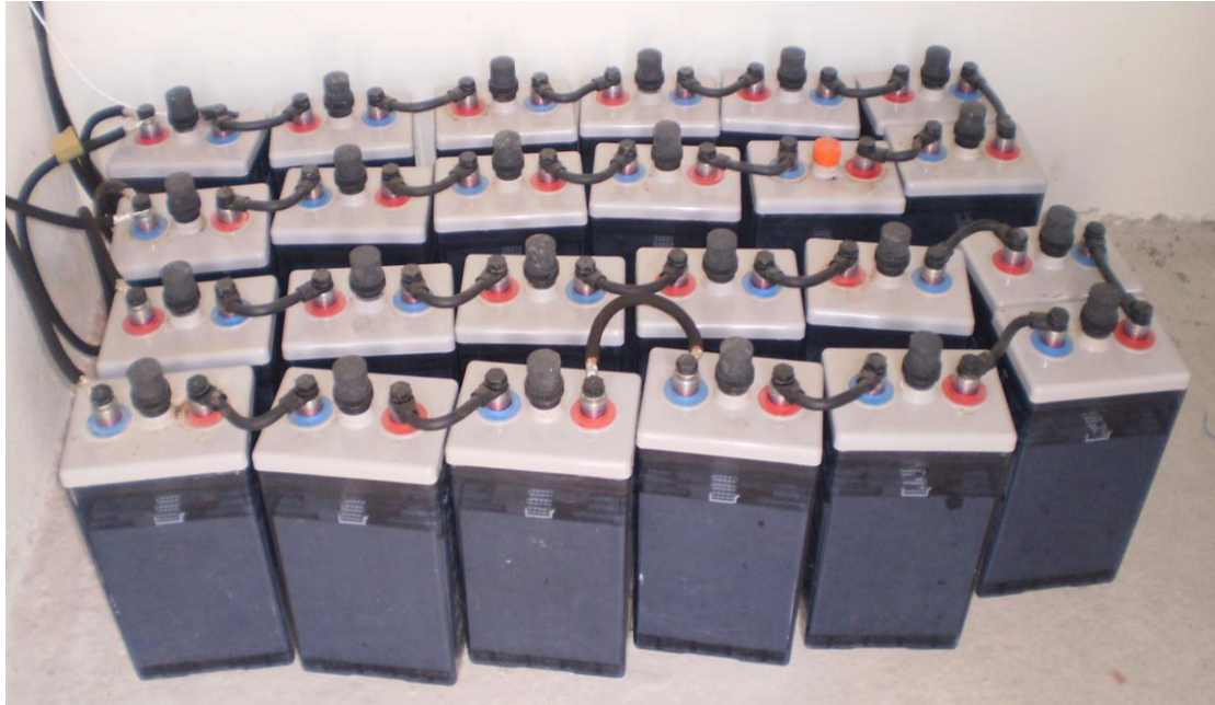
Σχήμα 4.4. Συστοιχία μπαταριών μικροδικτύου.
