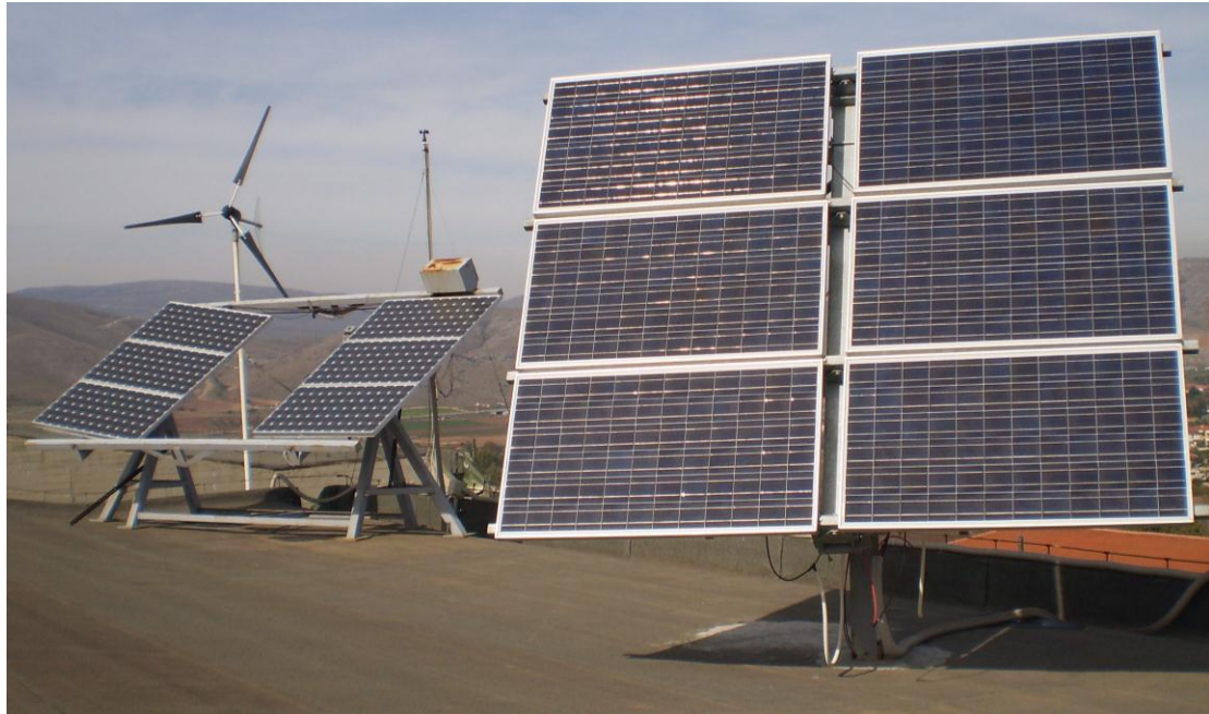
Σχήμα 4.6. Δύο φωτοβολταϊκές συστοιχίες μικροδικτύου
