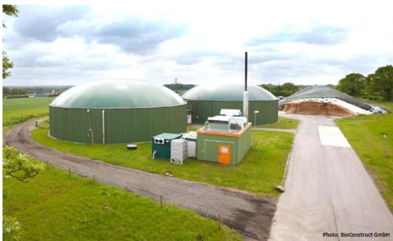
Σχήμα 1.1. Μονάδα παραγωγής βιοαερίου και ηλεκτρικής ενέργειας από βιοαέριο ισχύος 500 kW [Πηγή: Chair of Bioprocess Engineering, TU-Berlin – BioConstruct GmbH]
